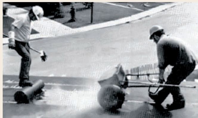
Applicazione di impermeabilizzazione in multistrato di bitume ossidato fuso e cartoni bitumati.
