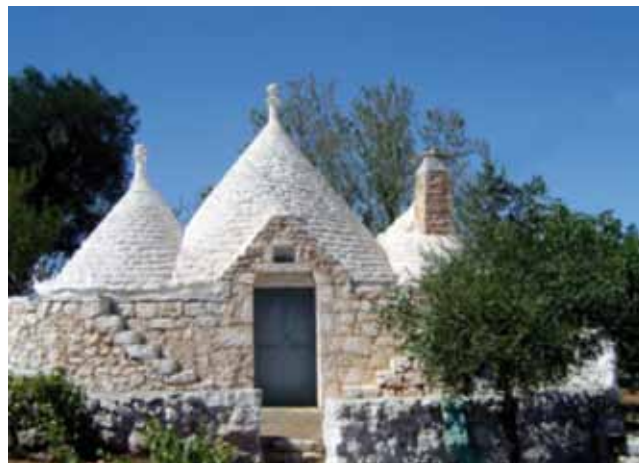
Esempio di sistema di copertura discontinuo, realizzato con lastre di pietra sovrapposte
