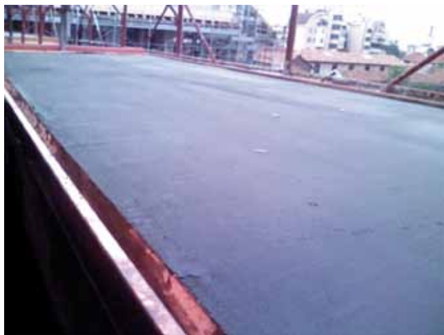
Esempio di sistema di copertura continuo, realizzato con resine cementizie bicomponenti
