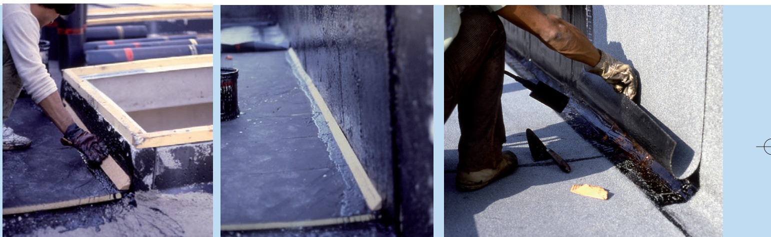
Sequenza di esecuzione di una guscia prefabbricata.
