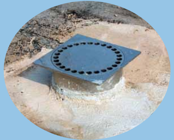
Posizionamento di griglia di scarico ispezionabile, su copertura impermeabilizzata. Si potrà scaricare (in qualche modo vista la minima presenza di fori sulla griglia) l'acqua presente sulla pavimentazione, ma l'acqua presente a livello dello strato impermeabile dove scarica?!
