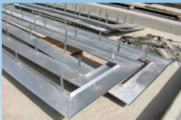
Corretta metodologia di posa di grigliato, con telaio/scossalina di protezione sagomato a "C". Telai di grigliati, stoccati in cantiere, girati con in vista la parte inferiore, dove oltre i gocciolatoi laterali si notano anche le staffe di fissaggio perimetrali interne.
