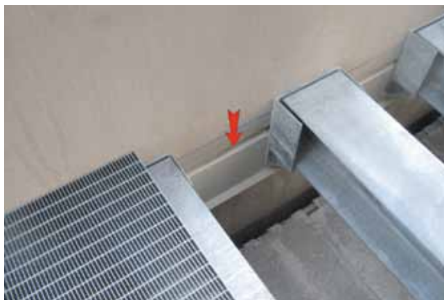
Corretta metodologia di posa di grigliato carrabile, su travetti d'appoggio, terminanti contro una parete. Prima del posizionamento delle tasche metalliche di appoggio dei travetti lungo la parete, è stata posta in opera una scossalina a gocciolatoio, fissata a parete ed inserita sul bordo superiore ripiegato, in una fresatura ricavata nella parete stessa e poi idoneamente sigillata.
