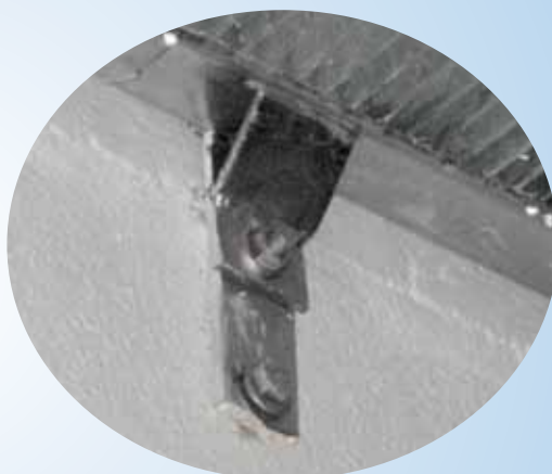
Corretta metodologia di posa di grigliato, con telaio/scossalina di protezione sagomato a "C". Particolare staffa di fissaggio perimetrale interna al foro del grigliato.
