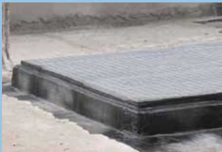
Membrana incollata, in modo errato, sull'aletta verticale del telaio, destinata a staccarsi in breve tempo.
