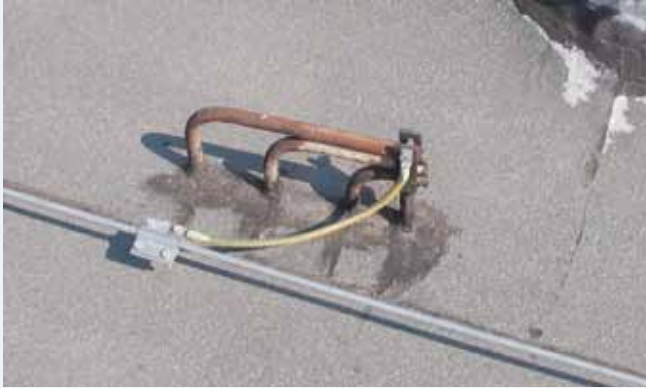
ATTRAVERSAMENTO DELLA MESSA A TERRA DIRETTAMENTE NELL'IMPERMEABILIZZAZIONE
