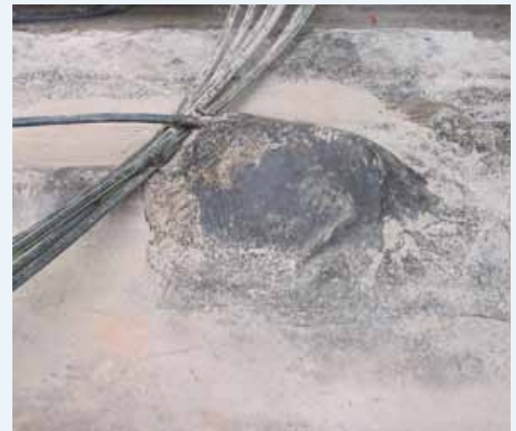
PASSAGGIO DI UNA TUBAZIONE DEL GAS ATTRAVERSO L'IMPERMEABILIZZAZIONE E IL SOLAIO
