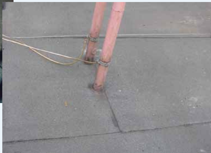
PASSAGGIO DI TUBAZIONI ATTRAVERSO L'IMPERMEABILIZZAZIONE E IL SOLAIO
