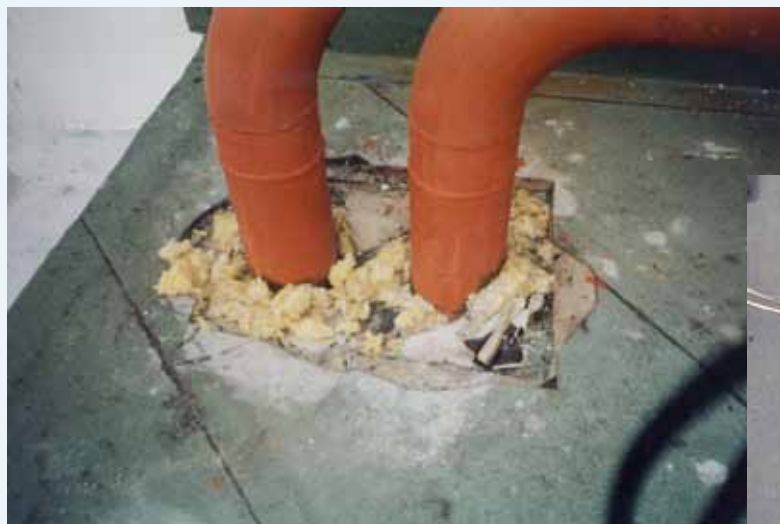
PASSAGGIO DI TUBAZIONI ATTRAVERSO L'IMPERMEABILIZZAZIONE E IL SOLAIO
