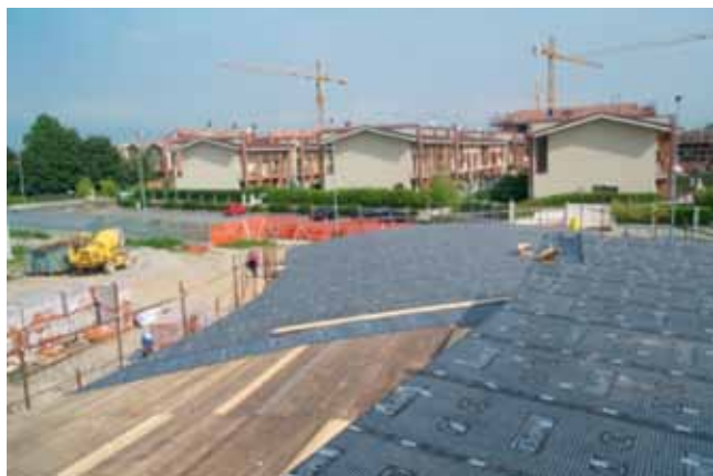
Nelle immagini, strato di desolidarizzazione e drenaggio orizzontale del vapore, in membrana in bitume polimero, accoppiata con NT di poliestere, posato con fissaggio meccanico su assito di legno
