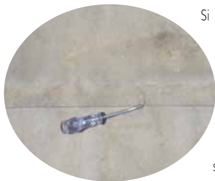
Controllo meccanico delle giunzioni dello strato impermeabile.
