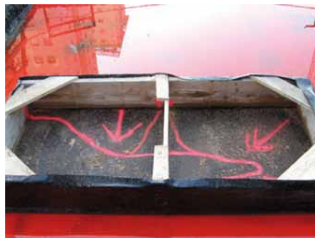
Collaudo con pozzetto d'ispezione aperto ed invaso esterno con acqua colorata.
