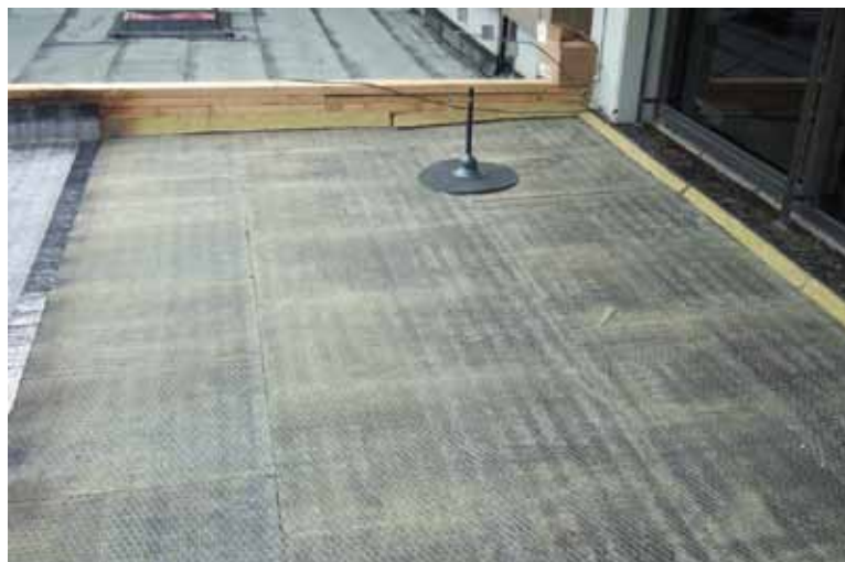
Sistema di rilevamento "Protectsys® B" con inserimento di retina in acciaio inox, conduttrice di corrente elettrica, direttamente all'intradosso dello strato impermeabile.
