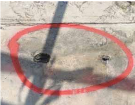
Controllo visivo dello strato impermeabile.
