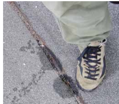
Controllo visivo dello strato impermeabile, operando pressione sulle sormonte di saldatura.
