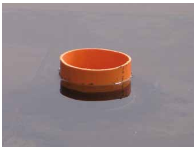
Chiusura scarico con tubo a sfioro (troppopieno di sicurezza).
