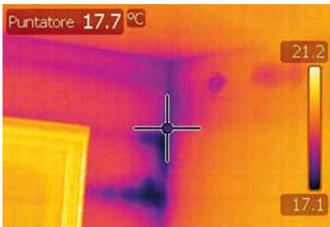
Collaudo di infiltrazioni a parete con termografia.
